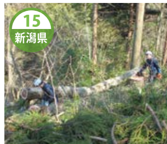
豪雪による倒木の伐採、撤去
